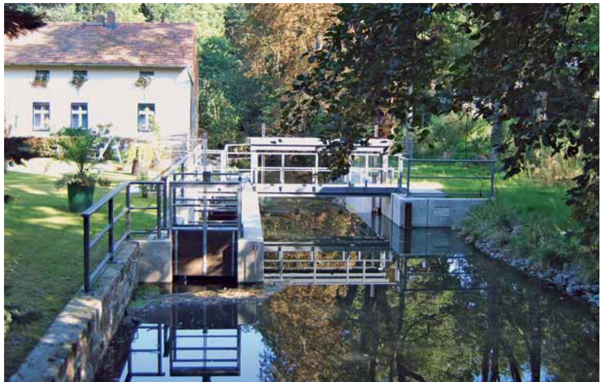
Das sanierte Mühlgrabenwehr in Kassel-Golzig.
